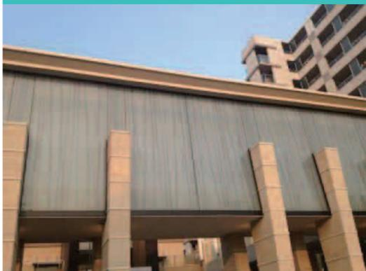
和紙・布・石目・木目のデザインデータをご用意して頂ければ、中間膜印刷合わせガラスで自然素材を挟み込んだようなガラスが製作できます。ガラスの小口を枠に納める仕様であれば外装使用も可能です！
